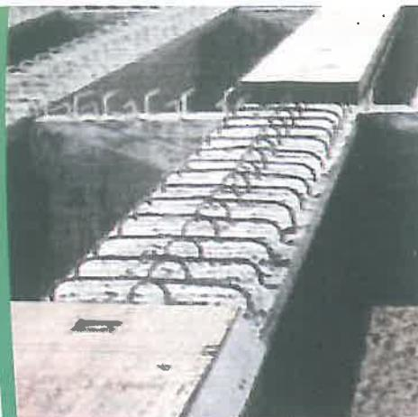
Dala de beton armătă cu armături composite din fibre de sticlă.
