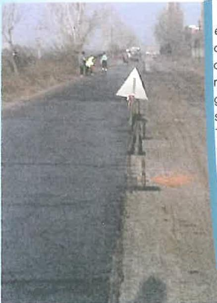
**Fig. 3. Banda amorsată cu bitum la sectorul experimental realizat pe șoseaua de Centură a Municipiului București**
