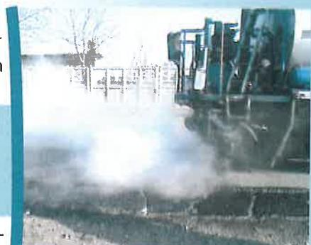
Fig. 2. Amorsarea cu bitum a îmbrăcămintei degradate
