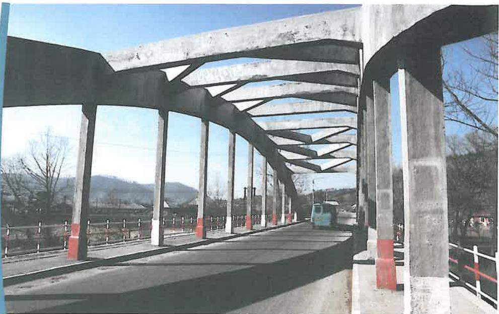
Podul cu arc cu tiranți peste Iza, pe D.N. 18
