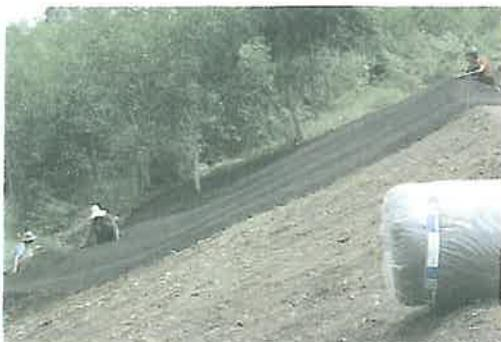
Pentru susținerea pământului vegetal cu care se acoperă taluzurile, pe lângă soluțiile tradiționale cu carioaje din beton (japoneze, Y), un interes deosebit (din punct de vedere al eficienței și al prețului de cost) îl reprezintă protecțiile ușoare de tipul geogrilelor spațiale, al plaselor din sfoară vegetală, al păturilor subțiri din paie țesute, etc. Peste aceste protecții se așterne pământ vegetal supraînsămânțat. Prin creștere, iarba fixează pământul vegetal de taluzul existent.
