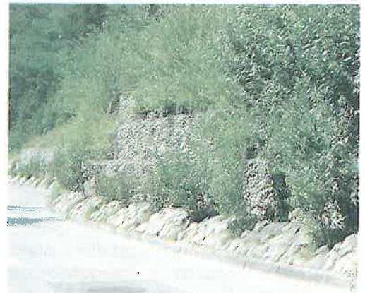
Dacă zidul are numai un rol de protecție atunci coșul din gabioane poate fi umplut cu pământ supraînsămânțat la partea exterioară. La fața gabionului se montează un geotextil cu rol de protecție a pământului vegetal până la dezvoltarea vegetației.
