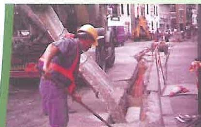
Utilizarea materialelor autocompactante pentru trasee drepte sau sinuoase
