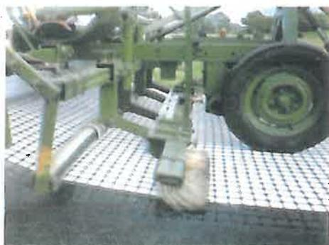
Geogriurile TENSAR asigură o creștere a duratei de viață a covorului asfaltic, de cca 10 ori, reduc apariția fisurilor și formarea făgașelor, reduc grosimea covorului asfaltic cu 40%. Îmbrăcămințile bituminoase armate cu geogriurile TENSAR pot fi reciclate, datorită faptului că temperatura de topire a polipropilenei (165...170°C) este inferioară temperaturii de încălzire a bitumului (180 °C).
