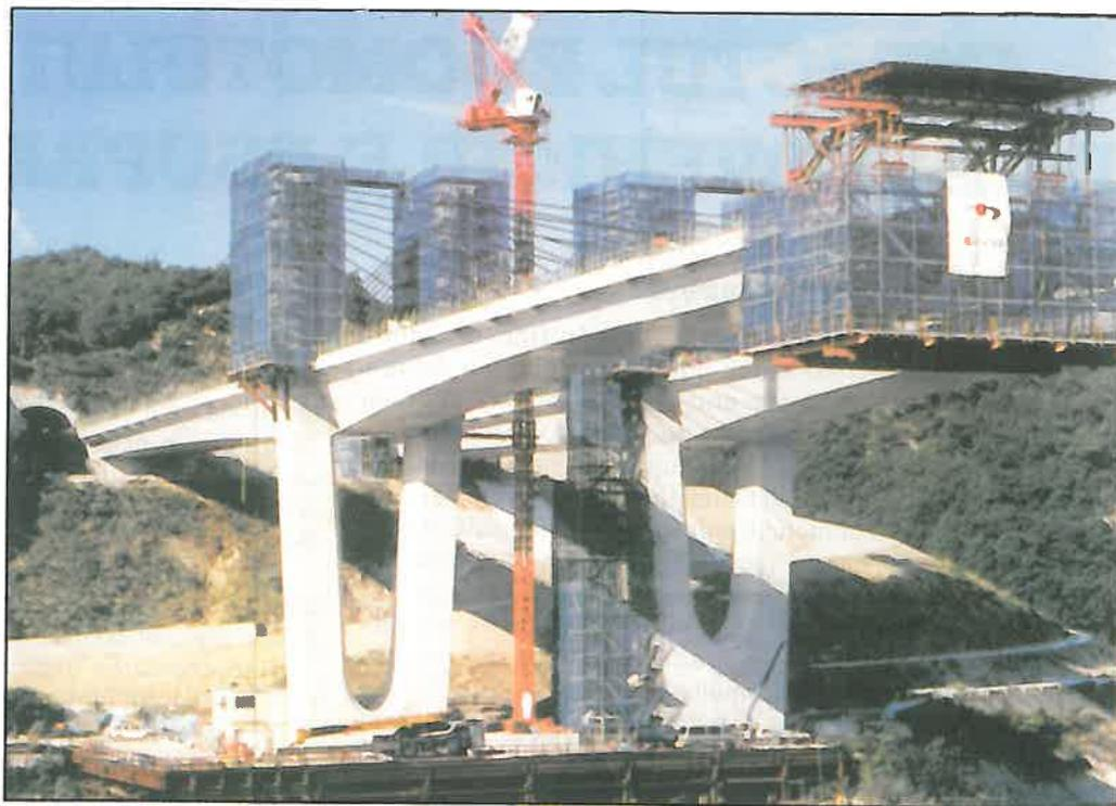
Fig. 4 Execuția structurii cu cofraje glisante
