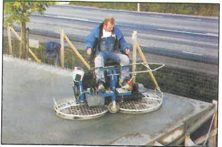
Mașina execută simultan, operații de rabotare și nivelare a suprafețelor de beton, cu o viteză de lucru reglabilă, între 40 și 130 treceri/min. și cu o presiune pe suprafața de beton, reglabilă în funcție de duritatea betonului, fie prin modificarea hidraulică a unghiului lamelor de rabotare, fie prin înlăturarea lamelor de nivelare.
