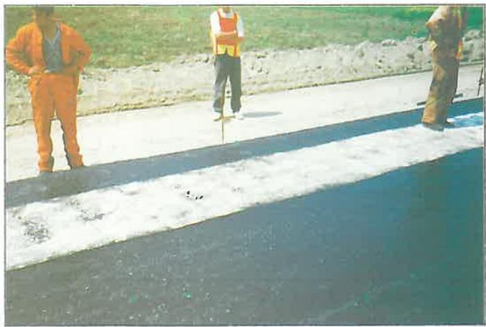
noul material a fost verificat la lucrările de reabilitare a autostrăzii A.1 București - Pitești, fiind aşternut peste îmbrăcămîntea existentă, sub straturile de legătură și de uzură, cu o tehnologie îmbunătățită.
