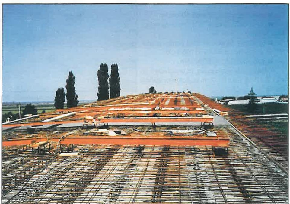
Fig. 4 Armarea plăcii de suprabetonare peste grinzile prefabricate
