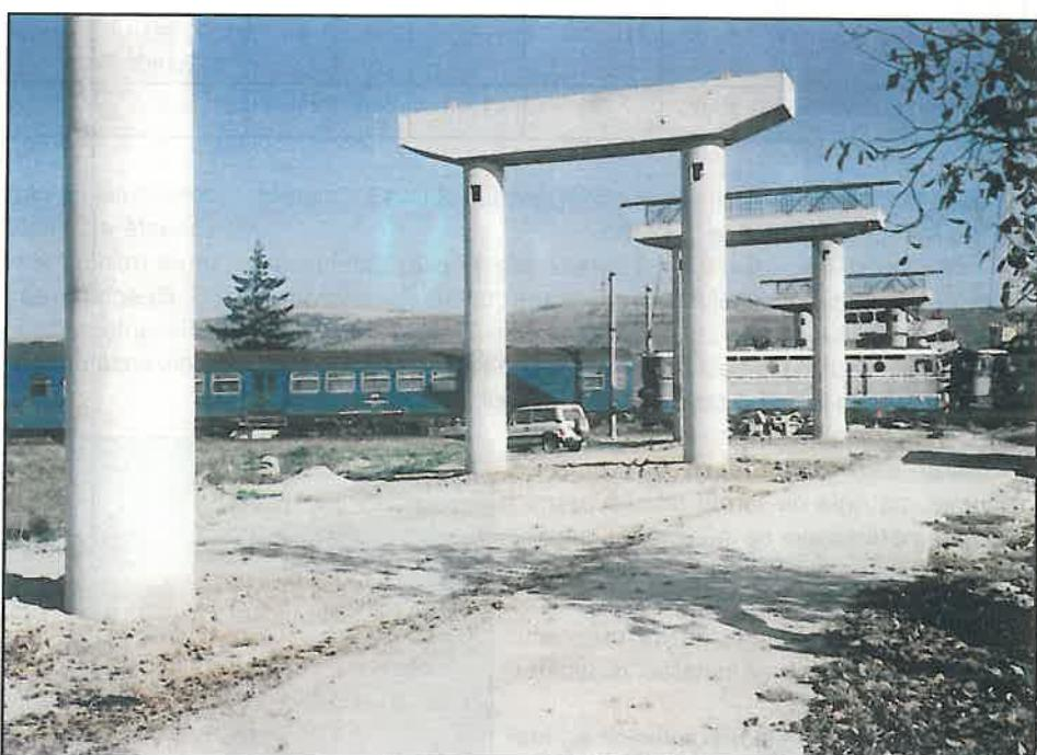
Fig. 2 Pile cadre din beton armat monolit. Vedere
