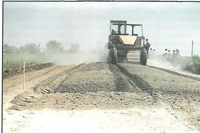
Stabilizarea prin sistemul CONSOLID se aplică pe drumuri de pământ, având un procent de cel puțin 20 % argilă prăfoasă, pe timp uscat, la temperaturi de minim +5 °C.
