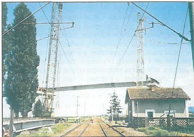
*Fig. 7 Montarea grinziilor în deschiderea centrală.
