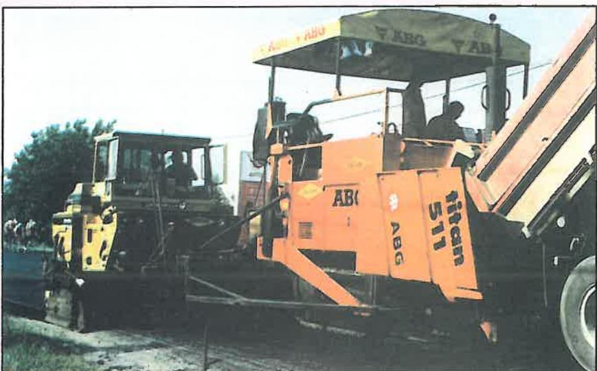
**SOROCAM** execută lucrări de retratate la rece a îmbrăcămintilor asfaltice degradate, prin sistemul "NOVACOL" cu utilaje de înaltă performanță.
