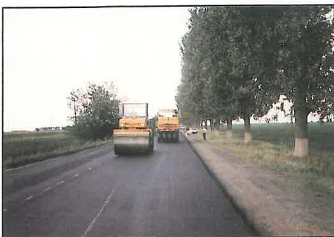
Fig. 11 Punerea în operație a mixturilor asfaltice cu repartizatorul MARINI
