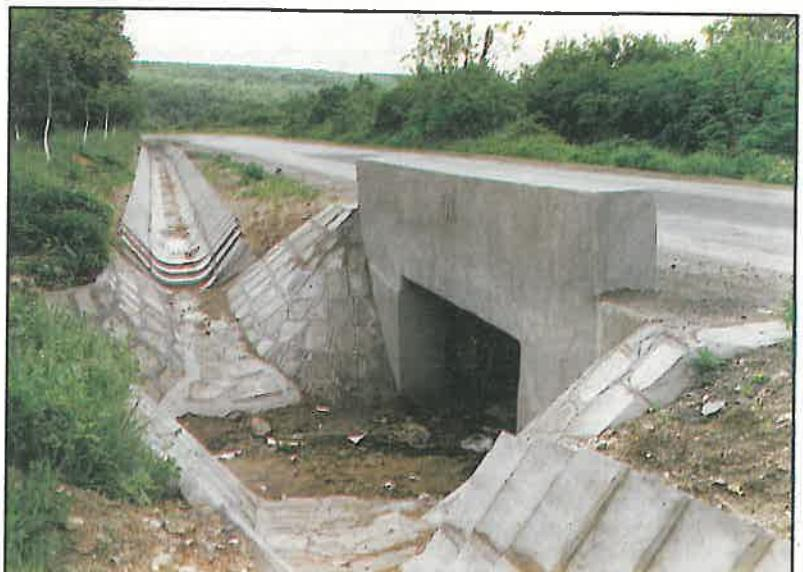
Fig. 8 Șanț realizat din elemente prefabricate, cu descărcare la un podeț datat, având coronamente supraînălțate
