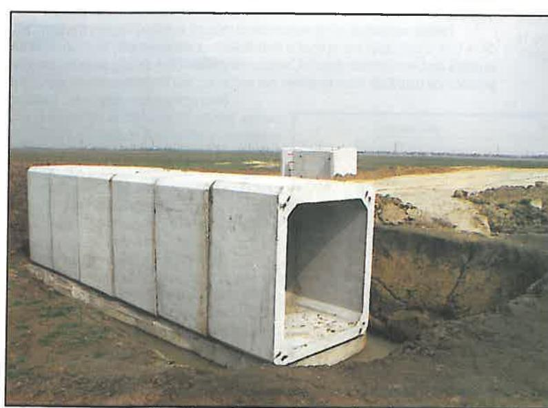
Fig. 7 Faza de execuție a unui podeț realizat din elemente prefabricate tip cadru
