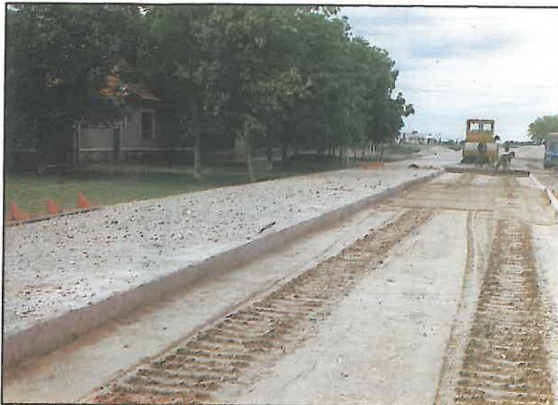
Fig. 6 Aspectul general al stratului realizat din balast stabilizat cu ciment, pe un sector de drum nou
