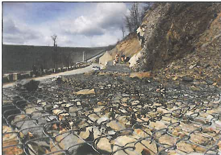
Realizarea gabioanelor, sau cum se pune ... muntele la pachet !
