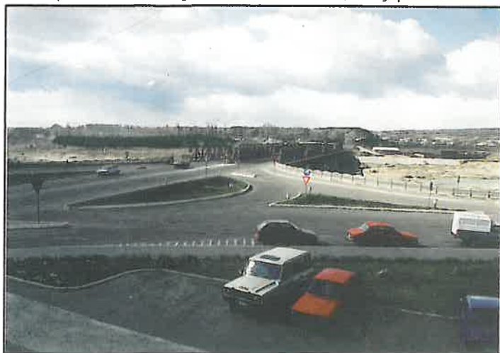
Modernizarea podului peste râul Râmniciu Sărat, pe DN2
