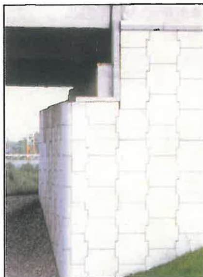
Fig.12 Culee de pământ armat (vedere laterală)
