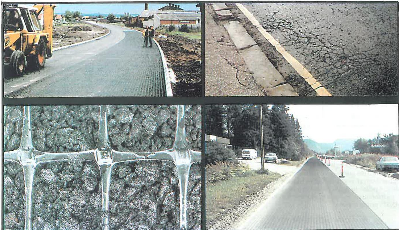
Geogriile conlucră cu materialul de umplutură, preluînd eforturile tangențiale, printr-un fenomen de încleștare mecanică.
