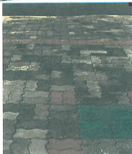
Sistemele rutiere realizate cu PAVELE din beton asigură o comportare corespunzătoare în timp, sub acțiunea combinată a traficului și intemperiilor, permitând îmbunătățirea etapizată a calității sistemului, în conformitate cu traficul actual și de perspectivă.
