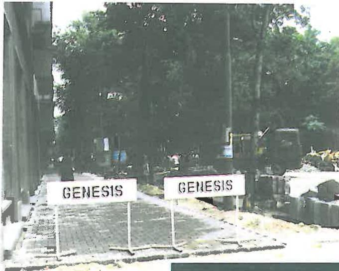
Sistemele rutiere realizate cu PAVELE din beton asigură o comportare corespunzătoare în timp, sub acțiunea combinată a traficului și intemperiilor, permitând îmbunătățirea etapizată a calității sistemului, în conformitate cu traficul actual și de perspectivă.
