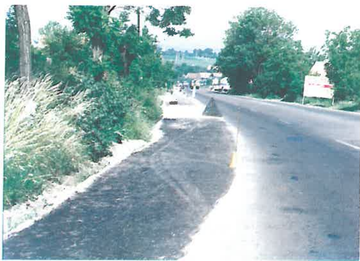
CONTRACT 5 - Așternerea balastului stabilizat pe DN1 km. 471 + 690
