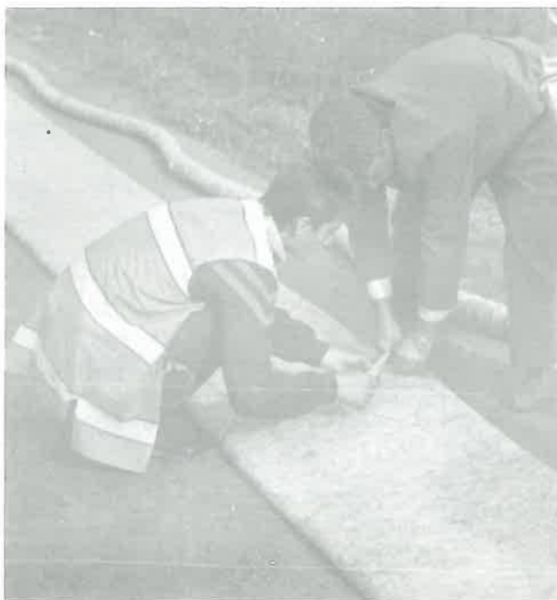
Foto 4 Acoperirea cu filtru geotextil a Plastidrenului și a tubului gofrat
