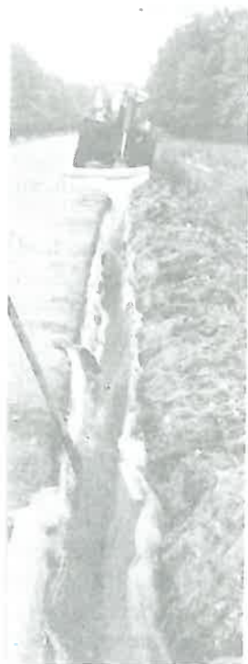
Foto 5 Ecran drenant executat pe DN 65 C Bălcești - Horezu
