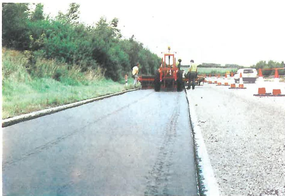
Fig. 2.1.4.1. Geotextil aşternut pe îmbrăcămîntea fisurată
