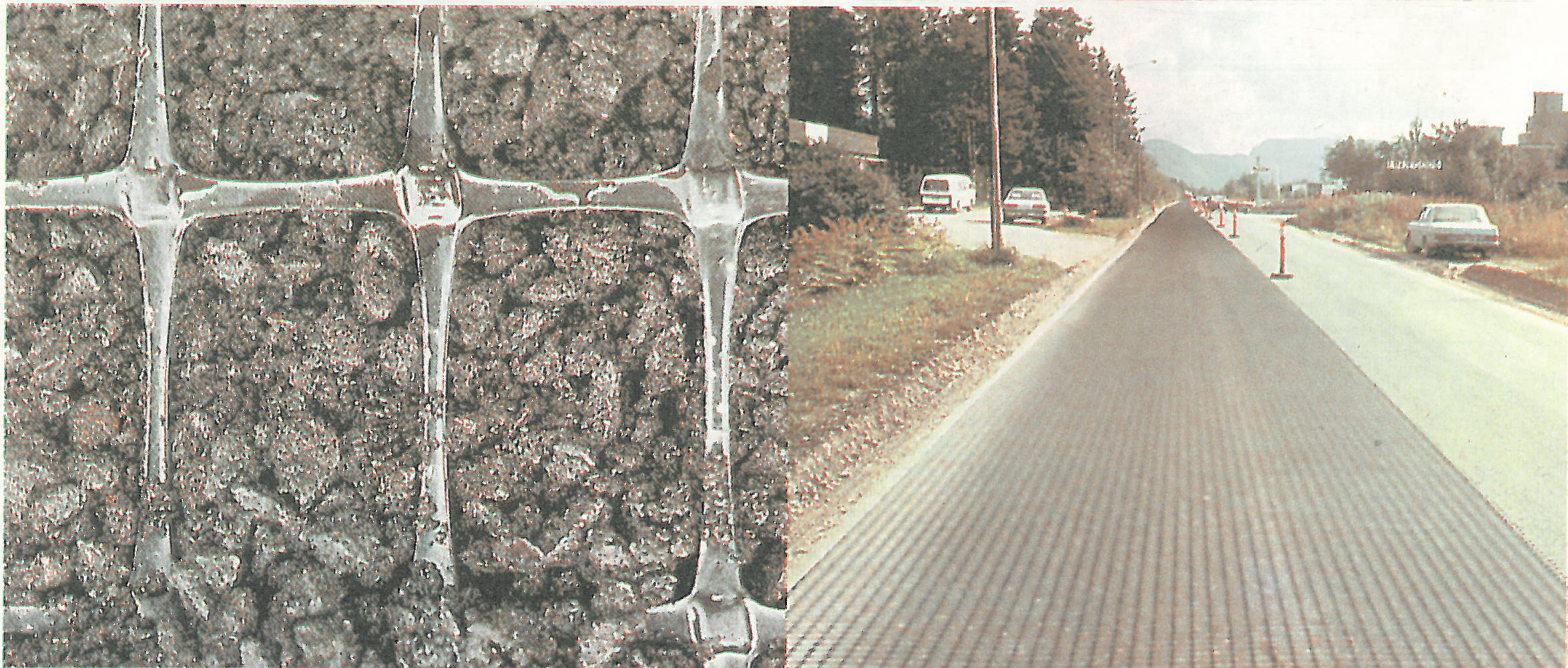
Geogriile conlucră cu materialul de umplutură, preluînd eforturile tangențiale, printr-un fenomen de încleștare mecanică.
