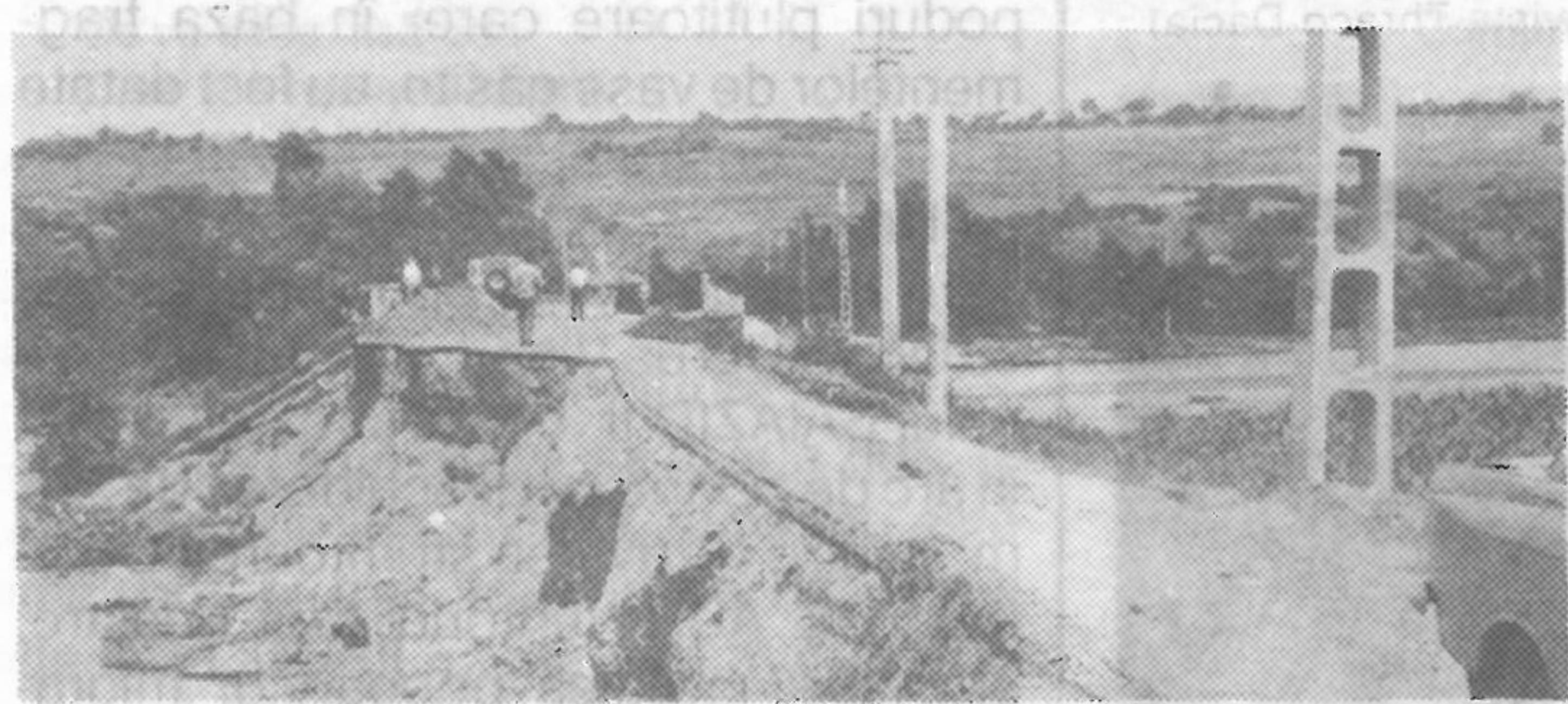
accesului prin vaduri, apoi s-a trecut la refacerea terasamentelor spălate și executarea de variante de circulație, pe poduri provizorii din grinzi metalice, prefabricate din beton și lemn, precum și a unor apărări de mal ușoare. Multe întreprinderi din toată țara și în special constructorii moldoveni, au sărit atunci în ajutorul nostru, cu utilaje, oameni și materiale, încît acțiunea de restabilire provizorie a circulației rutiere s-a desfășurat relativ repede.
